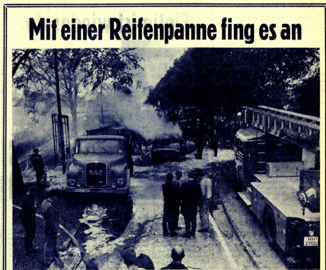
Der Tankwagen brannte vollkommen aus. Über zwei Stunden blieb die Straße für den Verkehr gesperrt.
