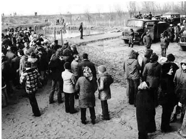
Bauplatzbefestigung und Polizei in Wyhl (oben) Wyhl (unten)
