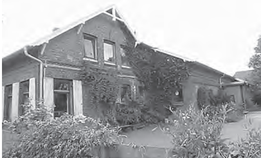
Erstes APO-Zentrum: Kirchwerder Landweg 2
